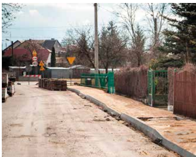
Remont ul. Staszica w Przystusze.
